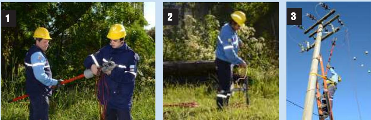
Esta operación se llevará a cabo mediante dispositivos y equipos especiales, previstos a tal efecto. Si la puesta a tierra se hace mediante seccionadores de tierra fijos, debe comprobarse que las cuchillas queden cerradas. Si no se dispone de puntos fijos para la colocación del morseto de puesta a tierra, es necesario acondicionar las instalaciones para que dichos morsetos hagan buen contacto.
